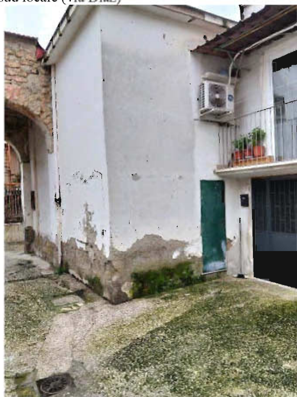
Figura 9 – vista confine nord (cortile interno)
