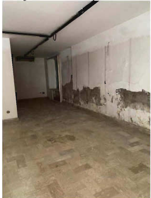
Figura 28 – vista 7 locale piano inferiore
