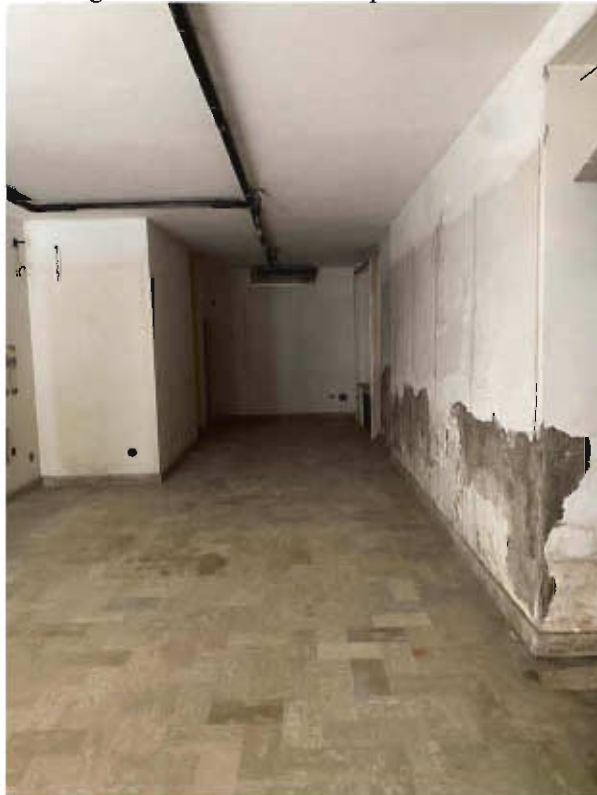
Figura 27 – vista 6 locale piano inferiore
