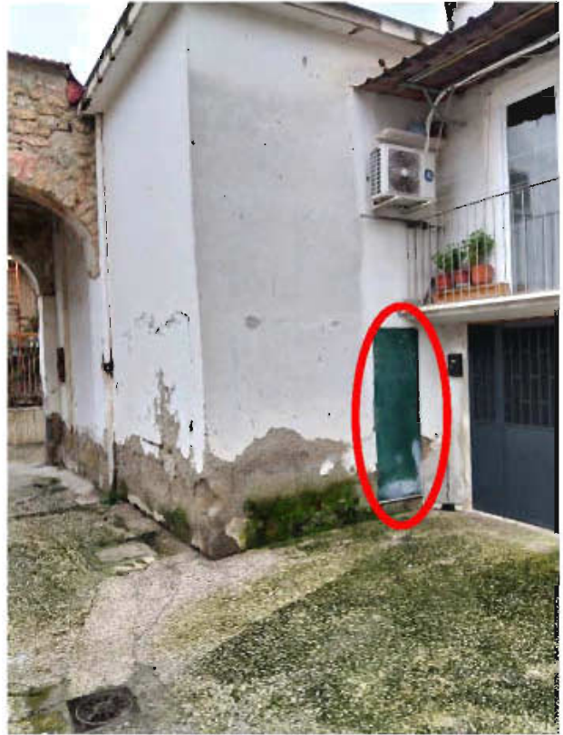
Figura 6- Porta esterna di accesso al cortile
