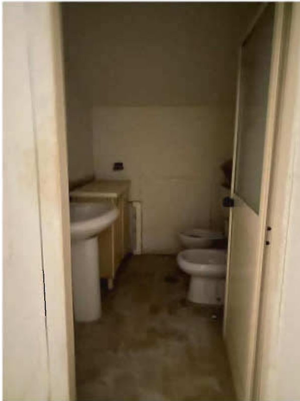
Figura 29 – locale bagno piano inferiore
