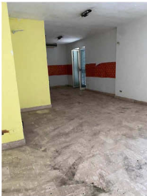
Figura 14 – vista 2 locale piano superiore
