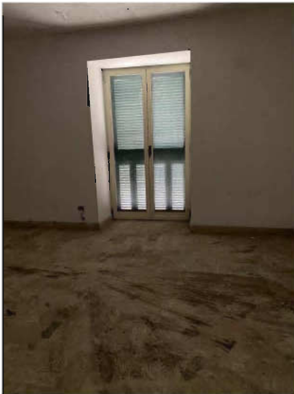
Figura 18 – vista 6 locale piano superiore
