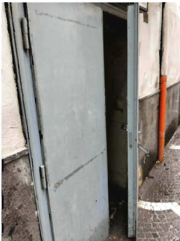
Figura 21 – ingresso locale piano terra dalla via Diaz
