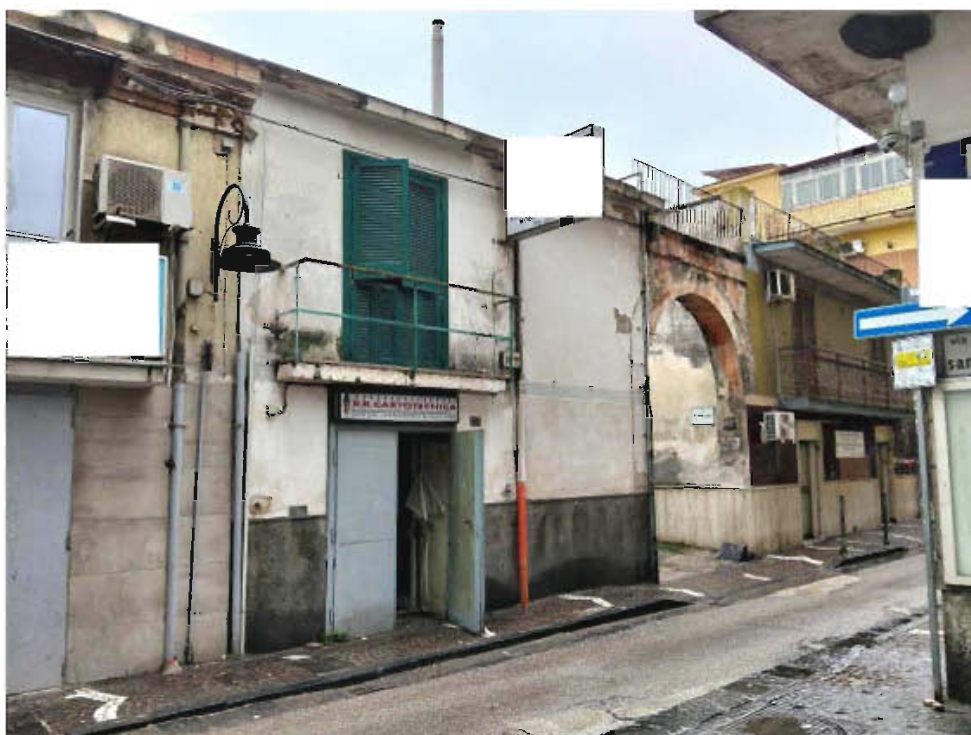
Figura 7- vista confine sud locale (via Diaz)
