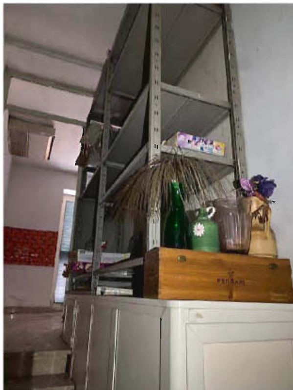
Figura 12 – vano di ingresso al piano superiore
