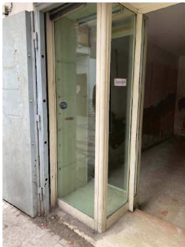
Figura 22 – vista locale piano inferiore
