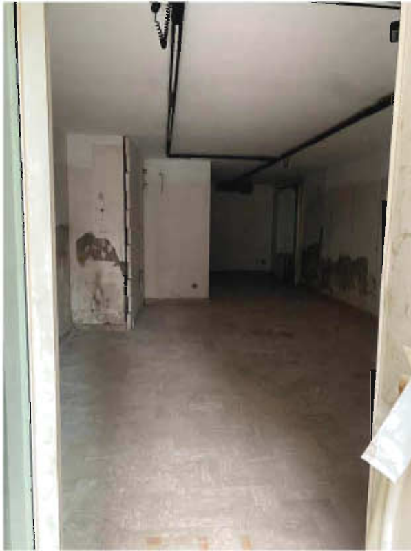
Figura 25 – vista 4 locale piano inferiore
