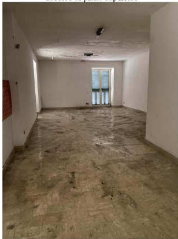
Figura 13 – vista locale piano superiore
