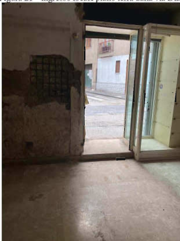
Figura 23 – vista 2 locale piano inferiore
