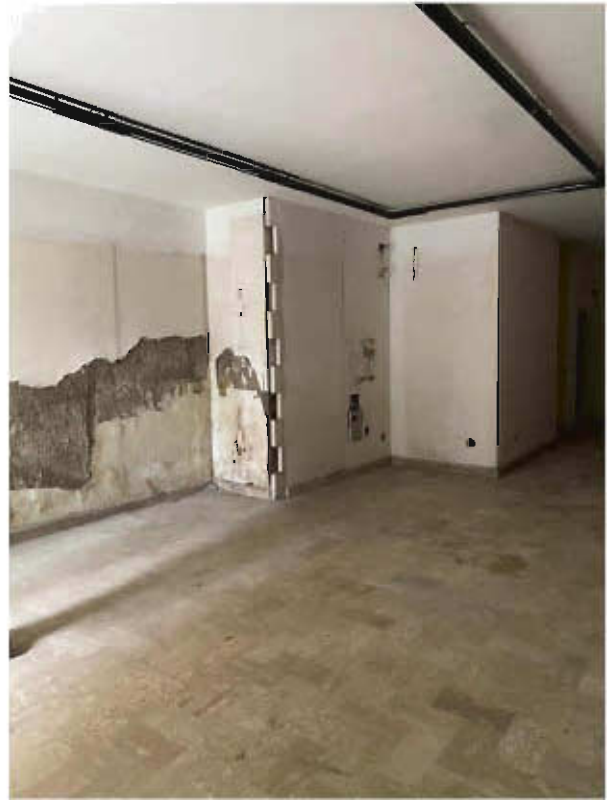
Figura 26 – vista 5 locale piano inferiore
